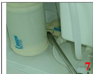
7 Com o auxílio de uma chave de fenda, retire o grampo trava, puxando-o para cima.
