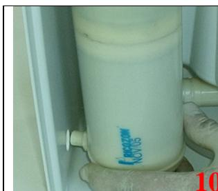
10 Em seguida, solte o elemento filtrante da lateral do gabinete, fazendo um esforço lateral.
